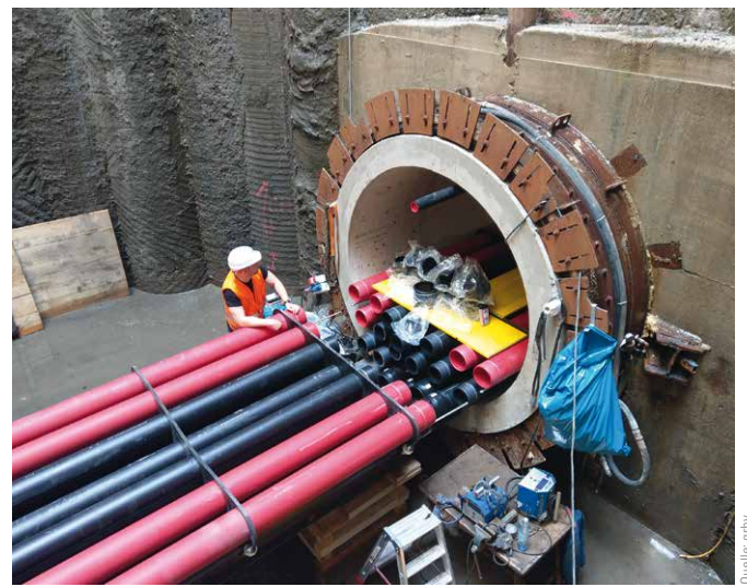
Bild 13 Beröhrung Tunnelquerschnitt Tunnel pipeworks
