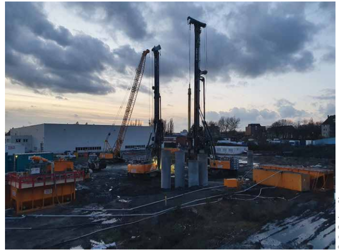
Bild 10 Einsatz von zwei Großbohrgeräten im Schichtbetrieb am Startschacht Use of two large drilling rigs in shift operation at the launch shaft
